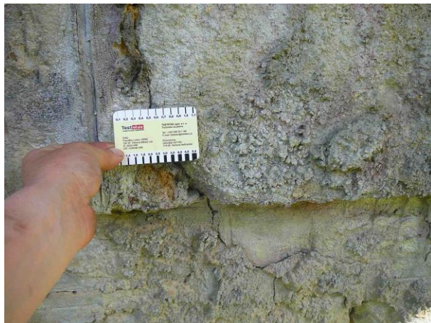
Trhlina v opěře přes zděný prvek
