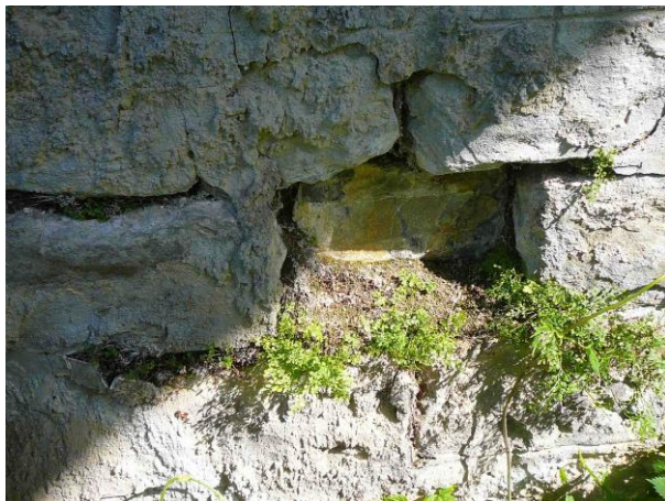
Chybějící kus zdícího prvku s travním porostem
