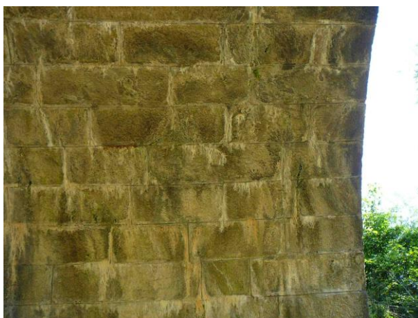
Výluhy po zatékání
