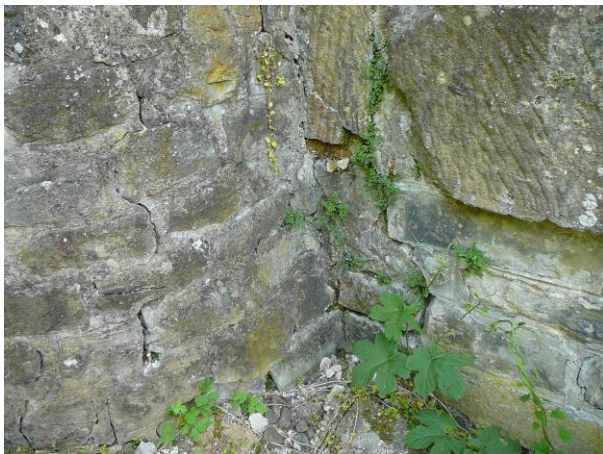
Trhliny na styku opěry a křídla
